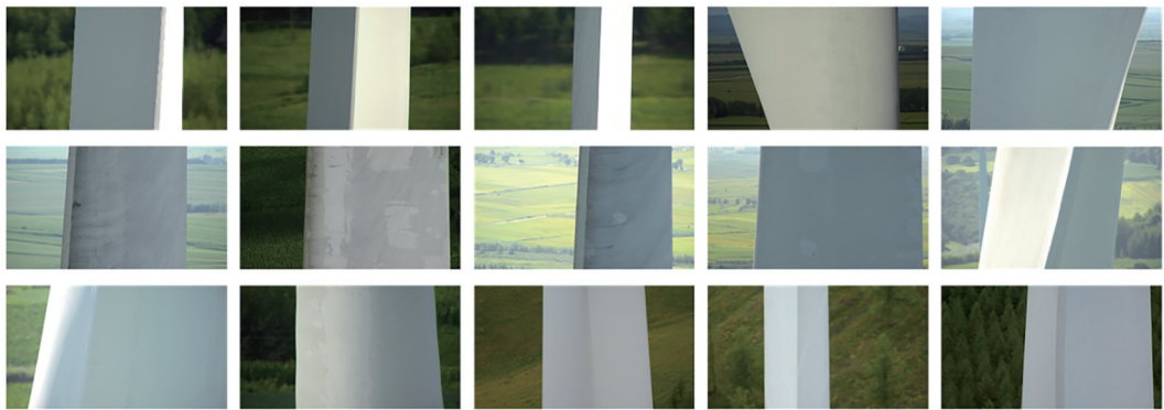
图 9 叶片损伤初步识别的典型示例 (正常风机叶片)
